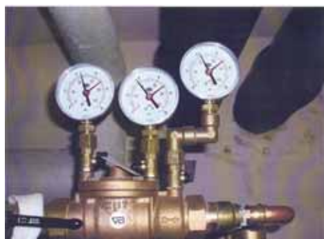
Figur 8.4 Billede af TBS ventil monteret med aflæsningsmanometre således, at det er muligt direkte at kontrollere ventilens funktion
